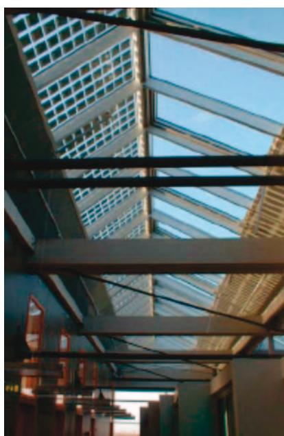
Figur 5. Eksempel på fast integrerede solceller, til venstre i et glastag, hvor solcellerne er opbygget i smalle striber, således at glastaget forbliver transparent (Schott Solar), og til højre i afgrænsede solcellemoduler, der filtrerer lyset..
