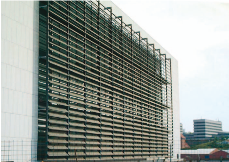
Figur 41. Foto af sydfacaden på Syddansk Universitet i Sønderborg, hvor prøvekontorerne er placeret ca. midt i billedet (med lidt mere åbne lameller end de øvrige kontorer, som har fast lamelhældning).
