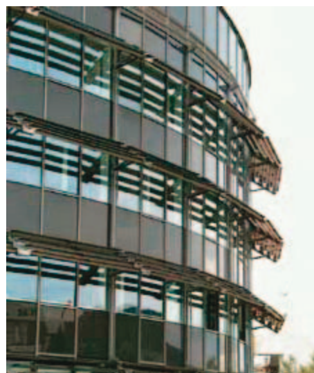
Figur 12. Wirtschaftshof kontorbygning i Linz (arkitekt H. Schimek) er et eksempel på en kombineret funktion af solafskærmning dagslysudnyttelse og PV. De øverste lameller er konstrueret som lys-dirigerende elementer, der øger dagslysudnyttelsen. Arealet af solcellerne er i alt ca. 250 m 2 , hvilket giver en elproduktion på 15.900 kWh eller ca. 40 % af bygningens elforbrug.
