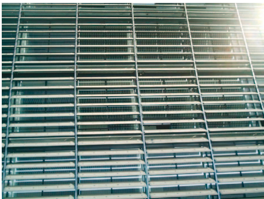
Figur 62. Fotos af sydfacaden på Alsion, SDU.
