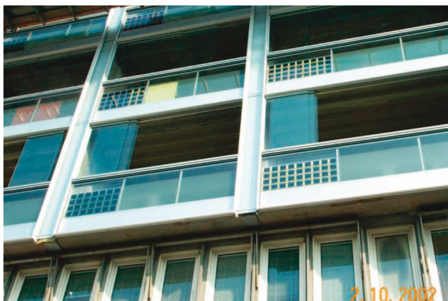
Figur 16. Solceller bag glas i facaden på Kollektivhuset på Hans Knudsens Plads, København.
