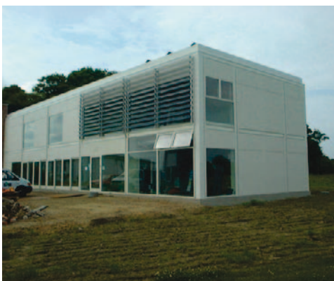
Figur 10. Billederne viser ALU PV systemet i færdig udførelse i Studentehuset i Herning opført i foråret 2003. Projektet, som er støttet af Energistyrelsens "BIPV program", er blandt andet en demonstration af dette projekts udviklede Al lameller. Billederne viser ALU PV systemet i færdig udførelse.
